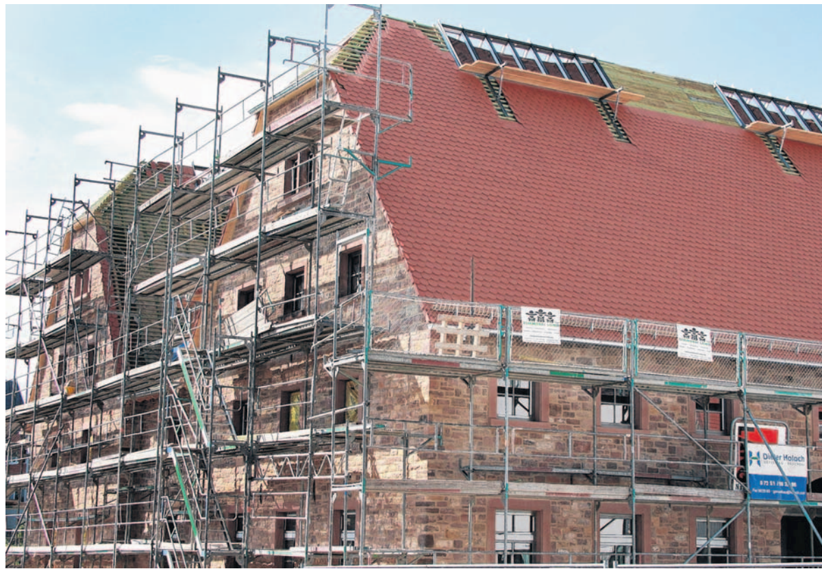
Immer mehr Kontur nimmt die Zehntscheune in der Mülhstraße an. In der zweiten Septemberwoche kommen die letzten Ziegel aufs Dach – dann ist das Gebäude vollständig dicht.
